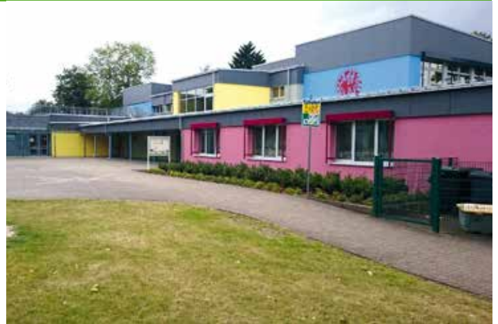
Energetische Sanierung der Grundschule Schneppenbaum
