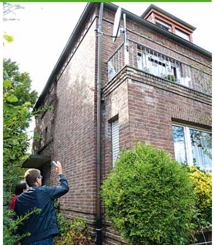
Bausubstanz Quartier – zweischaliges Mauerwerk
